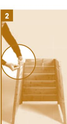
**2.** Visser les 8 crochets dans les avant-trous des montants : tête du crochet vers le haut.
